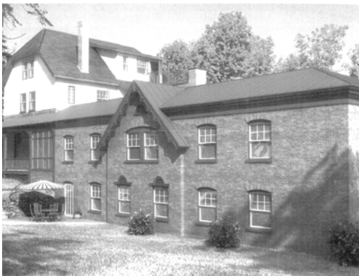
La Maison de la Coopération, 550 rue Dufferin
